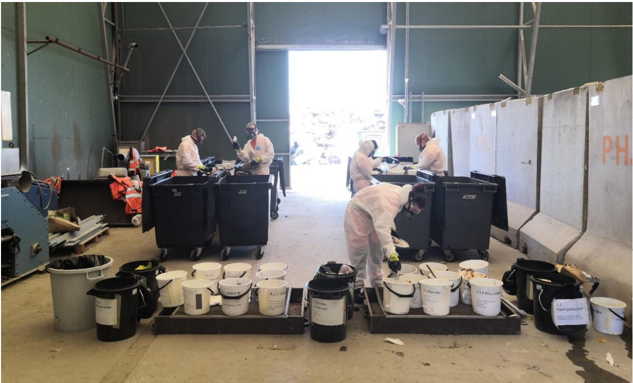
Kuva 7. Lajittelupöytien ympärillä suuriin jätteastioihin kerättiin useimmiten esiintyviä jätelajeja kuten muovia ja kartonkia. Muut jätelajeet lajiteltiin pienempiin ämpäreihin ja saaveihin.
